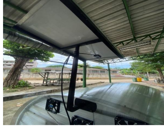
ภาพที่ 8 การติดตั้งแผงโซล่าเซลล์
