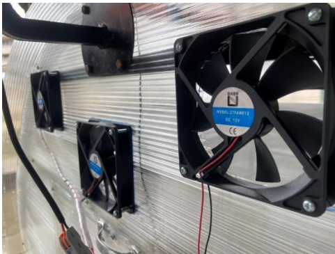
ภาพที่ 9 การติดตั้งพัดลมดูดอากาศขนาด 4.5 นิ้ว 3 ตัว
